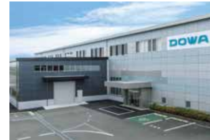
R&D Center (Hamamatsu-kita)
