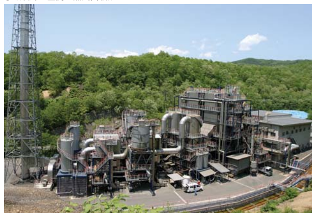
小坂製錬 金属・蒸気回収炉
