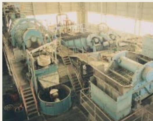
花岡鉱業土壌処理プラント
