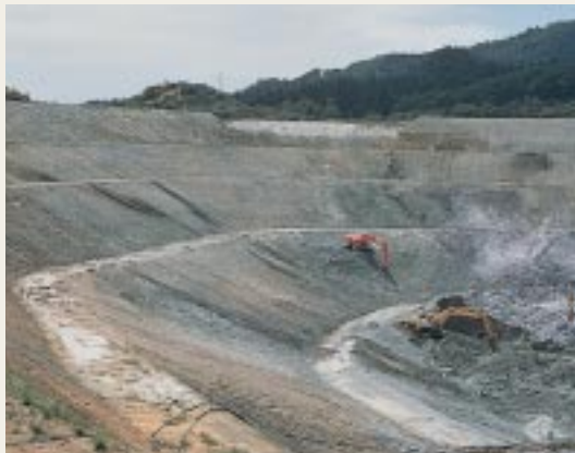
花岡鉱業 最終処分場
