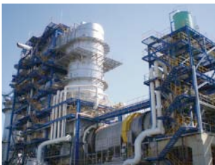
エコシステム千葉(株)新焼却炉
