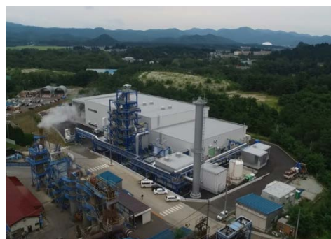
新焼却炉 外観（写真中央）
